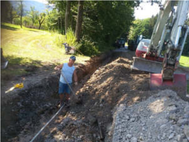
Güterwegsanierung am Kerschenberg tatkräftig unterstützt von Engelbert Teufel
