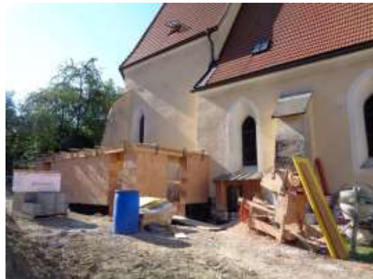
Neben dem Kulturzentrum wird auch schon eifrig an der Errichtung der neuen Sakristei für die Pfarrkirche gearbeitet.
